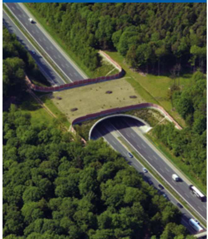
Vergleichbares Bauwerk einer fertiggestellten Grünbrücke
