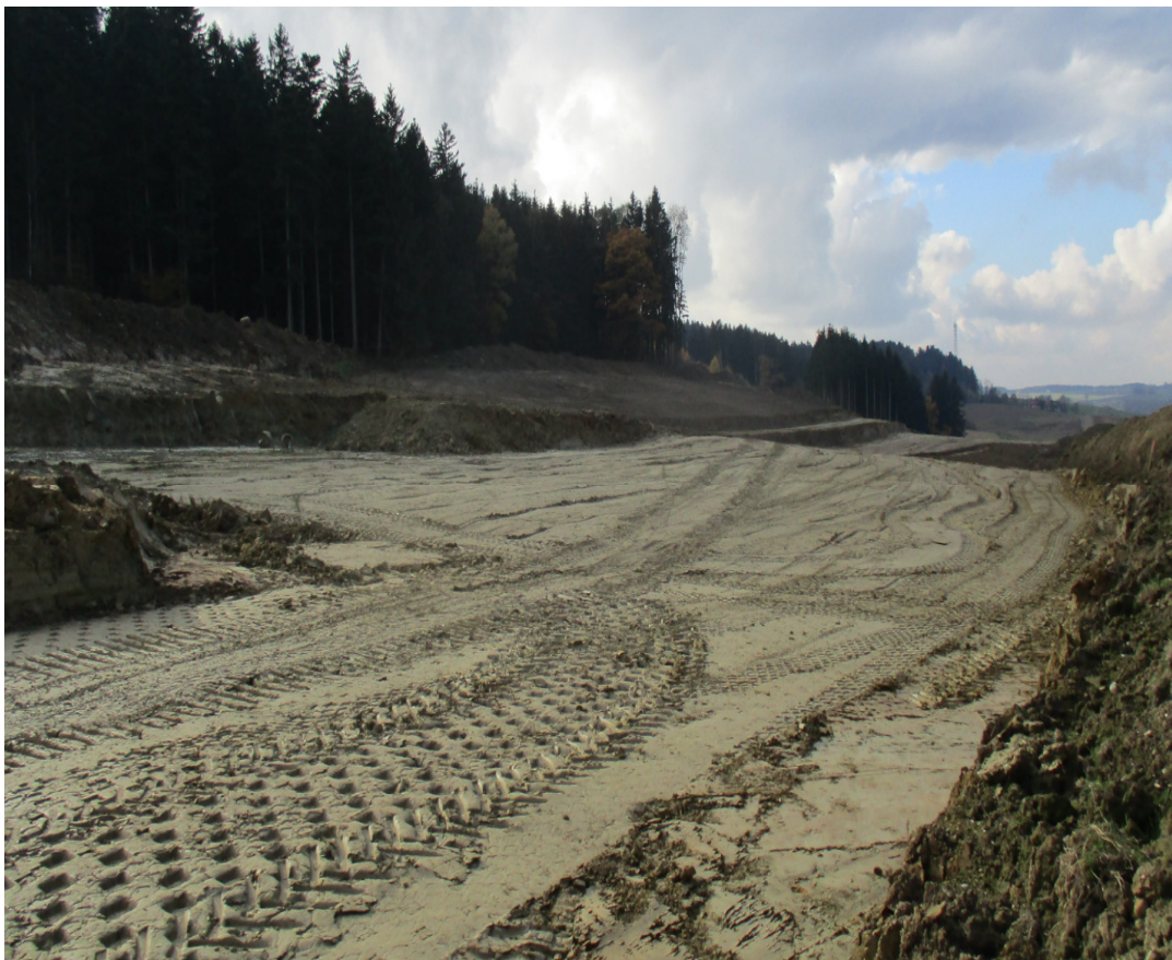
Abbildung 15: Erdbauarbeiten am Rande des Kopfsburger Forstes (Anfang November 2016)
