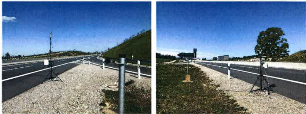
Abbildung 1. Messpunkte Planungsabschnitt 2, Fahrrichtung Ost.
