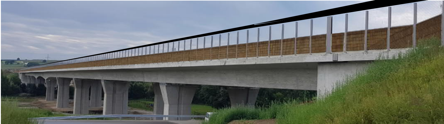
K 36/1: Erhöhung LSW durch Lärmspoiler um 0,50 m auf Goldachtalbrücke - Foto: ABDS
