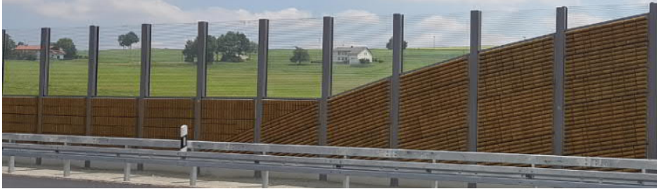
K 38/1a: transparente LSW-Elemente auf kurzer Brücke - Foto: ABDS
