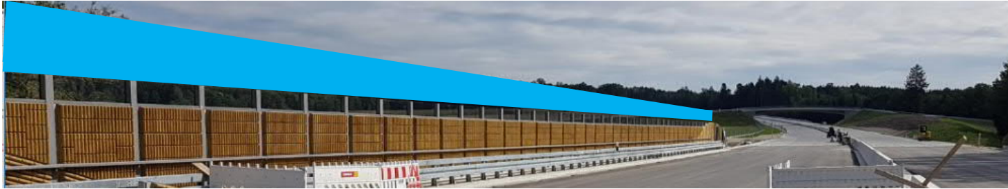
K 20/2: Erhöhung LSW 2,50 m um 2,00 m auf 4,50 m Höhe üb. Gradierte auf Hammerbachbrücke - Foto: ABDS
