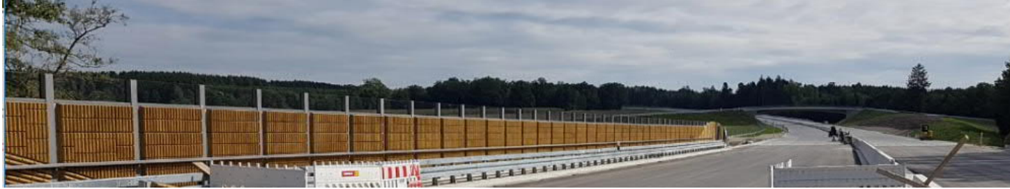
K 20/2: LSW 2,50 m Höhe üb. Gradiente auf Hammerbachbrücke - Foto: ABDS
