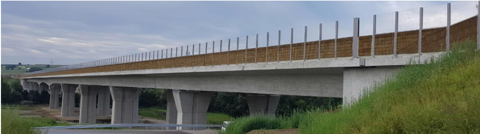
K 36/1: transparente LSW-Elemente auf Goldachtalbrücke - Foto: ABDS
