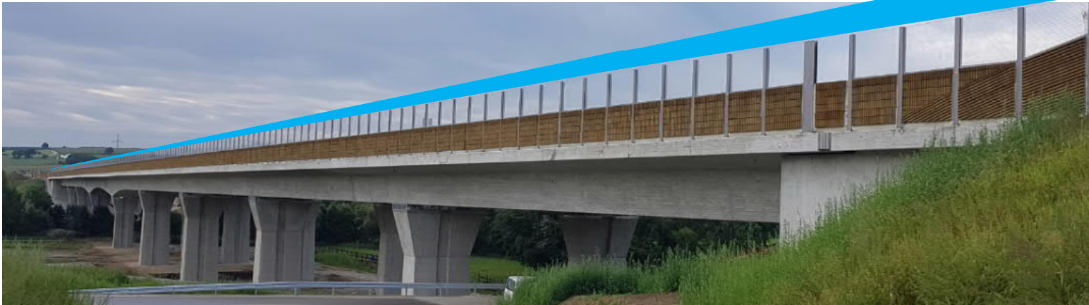
K 36/1: Erhöhung LSW 3,50 m um 1,00 m auf 4,50 m üb. Gradierte auf Goldachtalbrücke - Foto: ABDS
