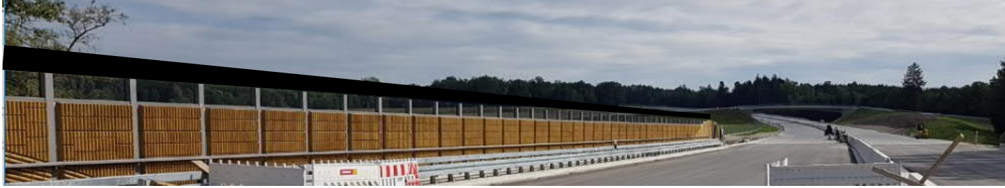
K 20/2: Erhöhung LSW durch Lärmspoiler um 0,50 m auf Hammerbachbrücke - Foto: ABDS
