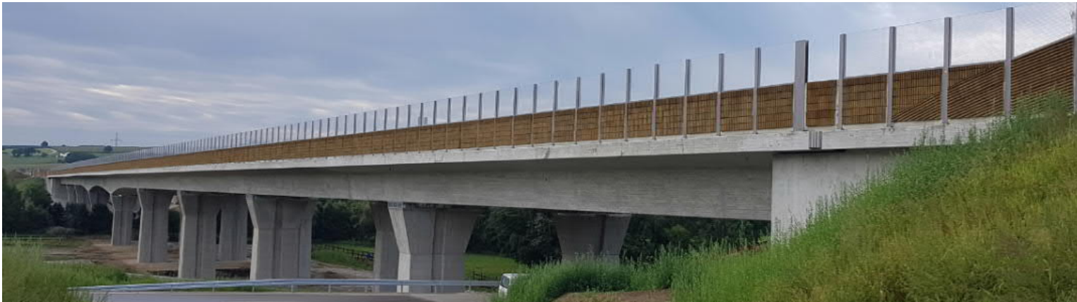
K 36/1: LSW 3,50 m Höhe üb. Gradiente auf Goldachtalbrücke - Foto: ABDS
