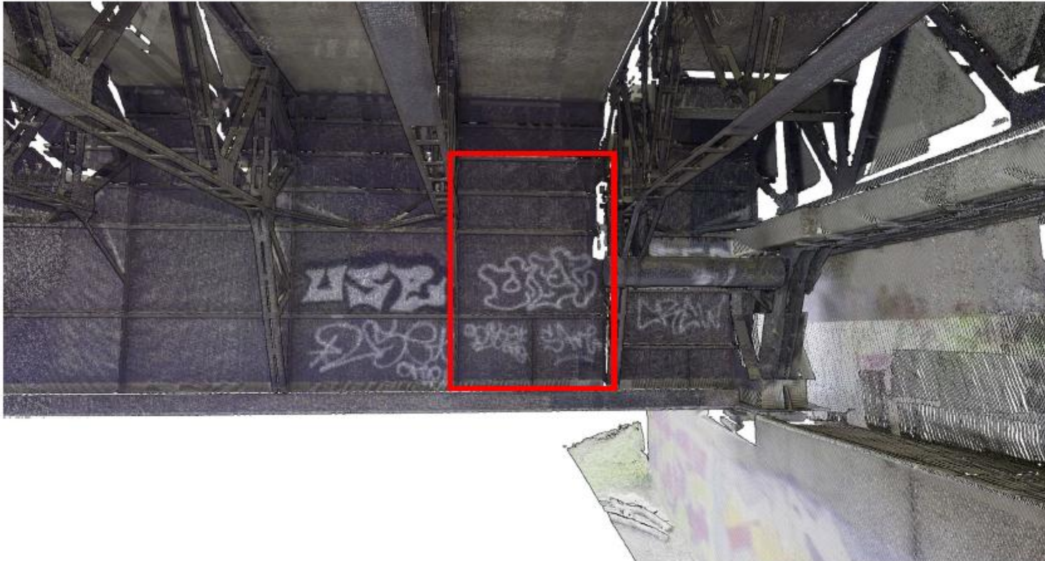
Analysierter Bereich – Widerlager Nord – Steg West
