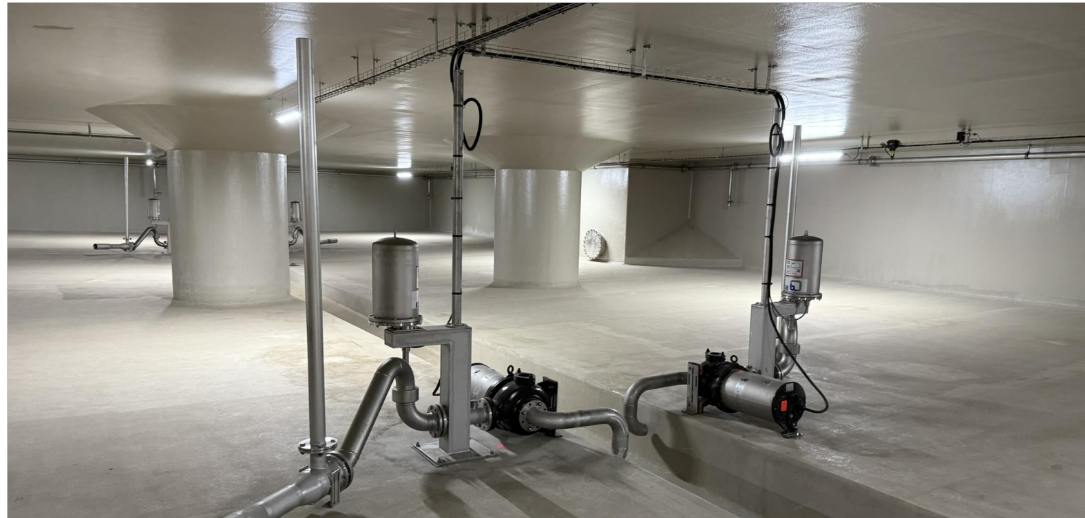
Stauraum Grenzallee mit Stahlbetonstützen zur Abfangung der Tunnelmittelwand
