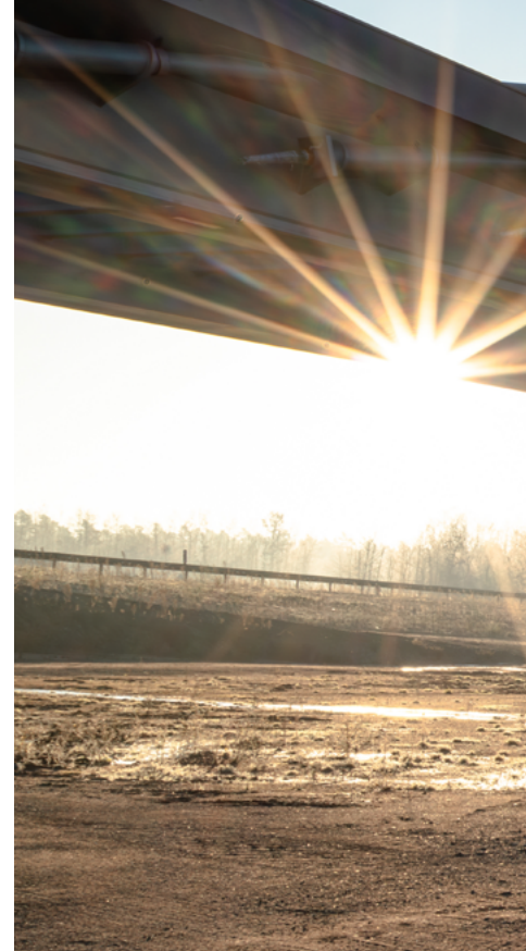
Halbdirekte Rampe „Overfly“ beim letzten Vershub im Dezember 2024
