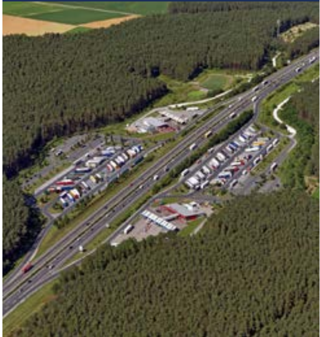
Tank- und Rastanlage Kammersteiner Land
