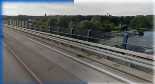
Auf dem südlichen Überbau fehlt der neben den drei Fahrstreifen anzuordnende Seitenstreifen. Dies ist sowohl in Bezug auf die Verkehrssicherheit als auch im Hinblick auf Verkehrseinschränkungen (Sperrungen der Fahrbahnen bei Unfällen oder bei Wartungs- und Instandhaltungsarbeiten) ein erhebliches Defizit und Auslöser für Umleitungsverkehre.
