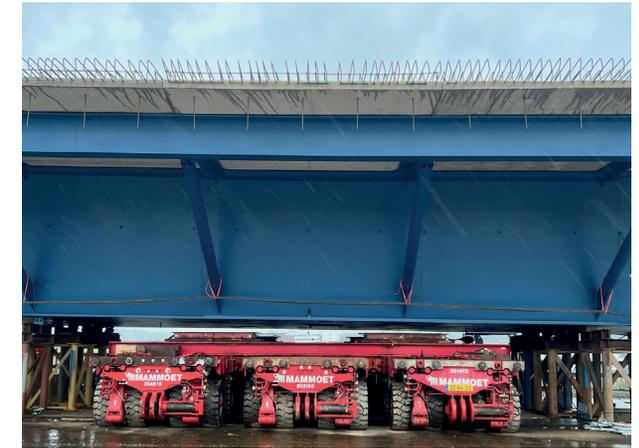
Ferngesteuerte Self-Propelled Modular Transporter (SPMT) transportieren den ersten Teil der neuen Haarbachtalbrücke im Dezember 2024
