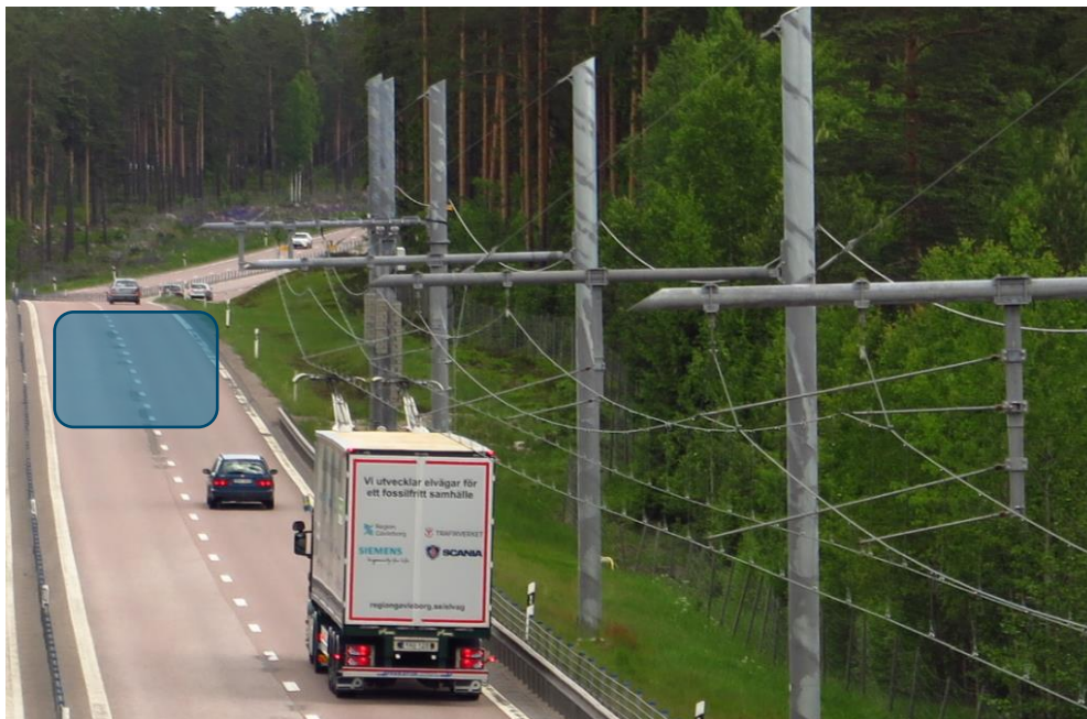
Abbildung 24: Landemöglichkeiten auf der Fahrbahn durch Unterbrechung der Oberleitung
