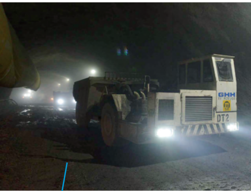
...das Schüttern bzw. Herausbefördern des Ausbruchmaterials mit Muldenkippern
