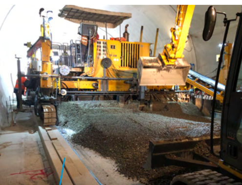
Auf den Tunnelbau folgt der Streckenbau mit dem Einbau der Betonfahrbahn.
