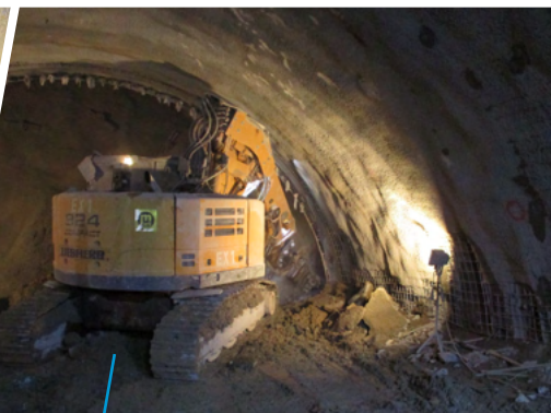
Der Vortrieb erfolgte je nach Gesteinsart mittels Sprengung oder Bagger.
