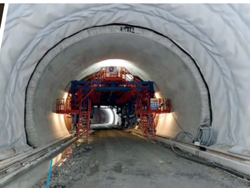
Die letzten Schritte im Tunnelbau: Herstellung der Betoninnenschale mit Hilfe eines Gewölbeschalwagens.
