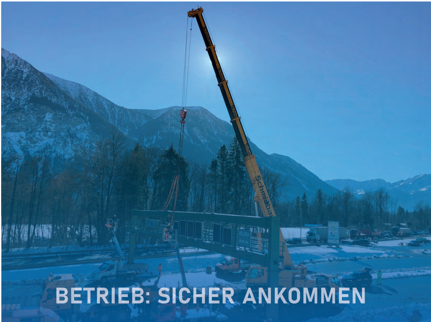
Aufbau einer digitalen Verkehrszeichenbrücke vor der Anschlussstelle Oberau - Nord.
