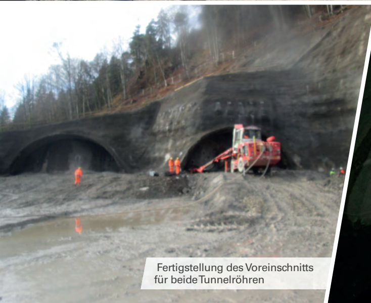
Der Voreinschnitt im Mühlberg wird mit Spritzbeton und Anker gesichert.
