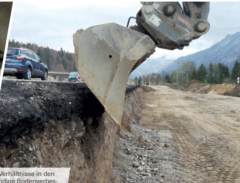
Ausbruch der Strosse mittels Baggern.
