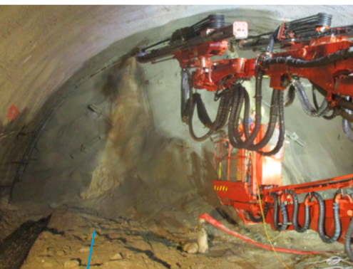
...und das Setzen von Ankern und Spießen.
