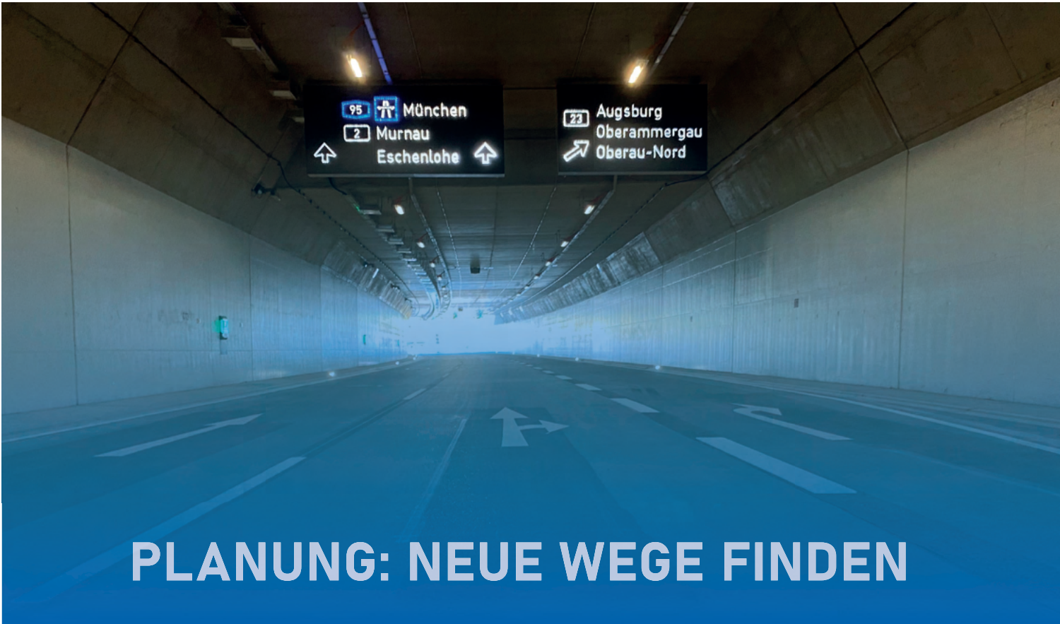
Innenansicht des Tunnels Oberau in Fahr- richtung München kurz vor der Anschlus- stelle Oberau-Nord.
