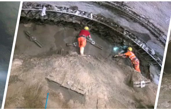
...und das Sichern durch den Einbau von Ausbaubögen,
