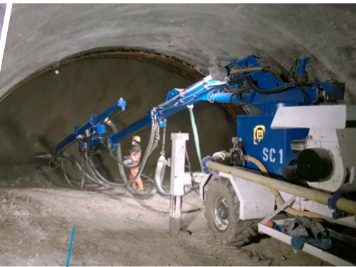
...durch das Aufbringen von schnellhärtendem Spritzbeton
