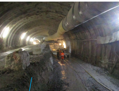
Ausbruch der Strosse
