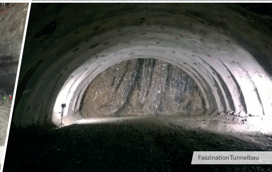
Fertigstellung des Voreinschnitts für beide Tunnelröhren
