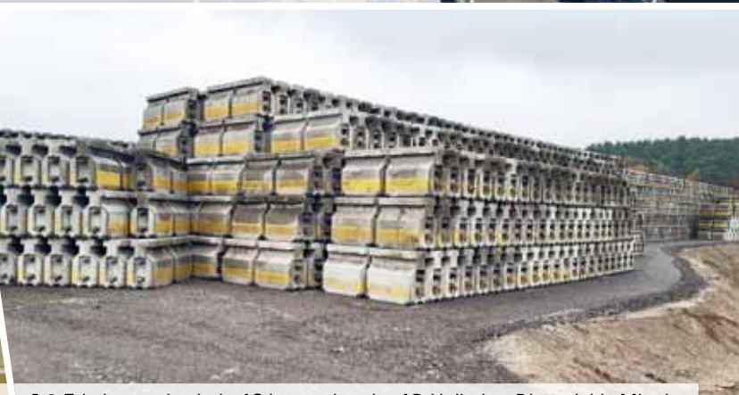
A 9 Erhaltungsabschnitt AS Langenbruck – AD Holledau: Die variable Mittelschutzwand des Road Zippers wurde mit Abschluss des Projektes abgebaut.
