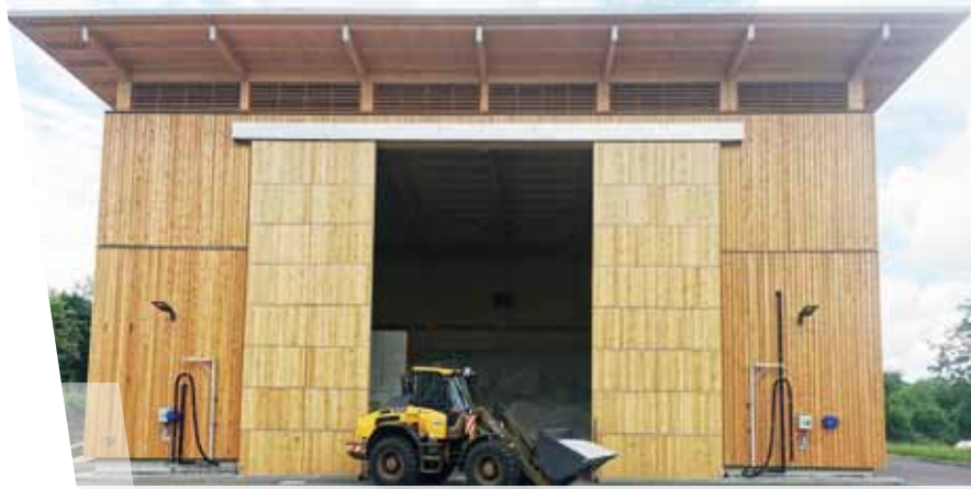
Autobahnmeisterei Heidenheim: Die neugebaute Salzhalle
