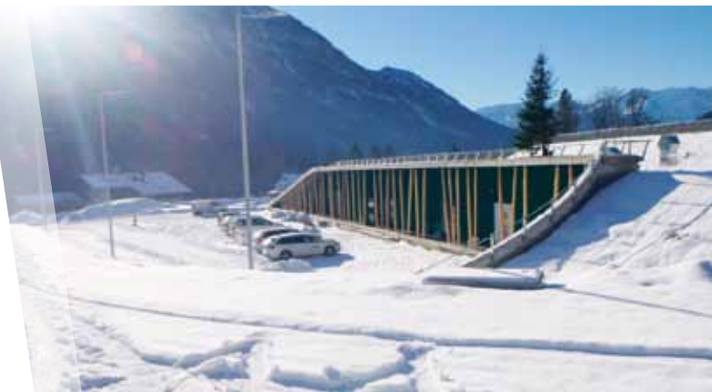
B 2neu Ortsumfahrung Oberau: Das Betriebsgebäude des Tunnel Oberau am Nordportal
