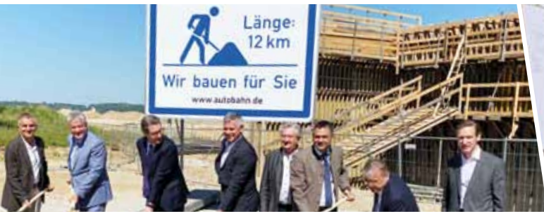
A 94 Bundesverkehrsminister Andreas Scheuer und Stephan Krenz, Geschäftsführer der Autobahn GmbH, feiern den gemeinsamen Spatenstich zum Neubaub Abschnitt zwischen Kirchham und Pocking.
